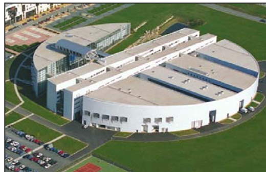
Vue aérienne de l'ENSMA
